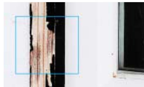
Abb.: Lackabrisse auf Altbeschichtung mit nicht geeigneten - zu stark klebenden - Abdeckbändern
