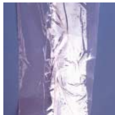
Ergebnis: Beschädigungen der Oberfläche durch verwitterte Bestandteile des PVC
