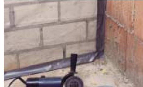
Abb.: PE-Folienverklebung mit tesa 4662
