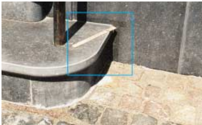
Abbildung: Farbveränderungen auf Naturstein nach Klebebandeinsatz auf Petit granit/ Belgisch Granit, Oberfläche geschliffen matt
